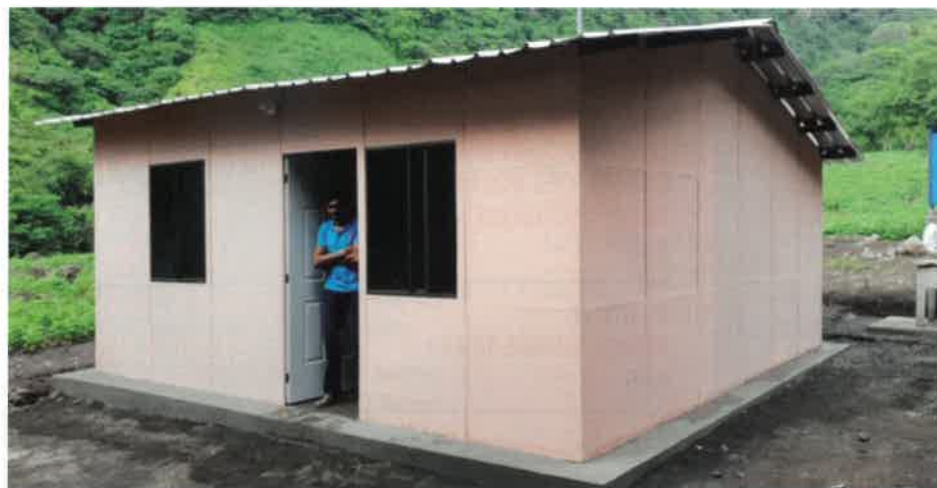
Les nouvelles maisons à La Trinidad sont construites avec minutie.
